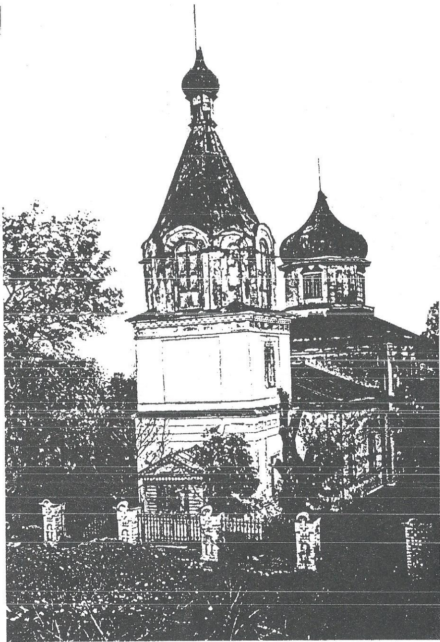
Общий вид церкви 1862 г. с юго-запада.
